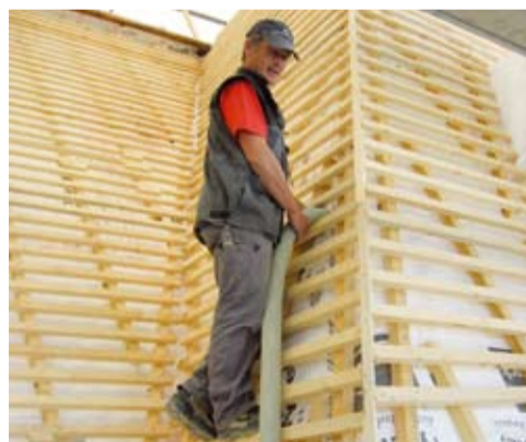
Les travaux sur le toit
