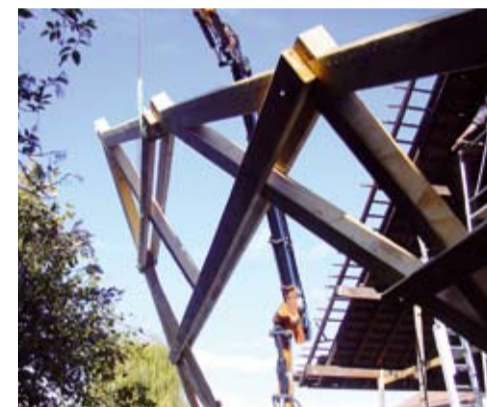
Hangar agricole, remplacement d'une ferme, Meinier
